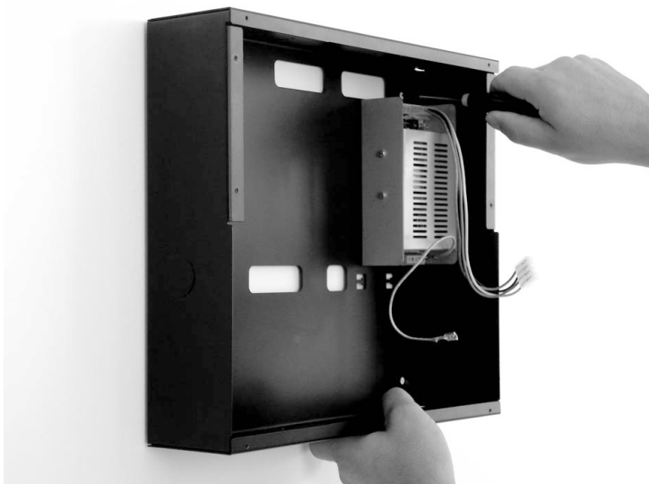
Figura 11 - Fissaggio della centrale
